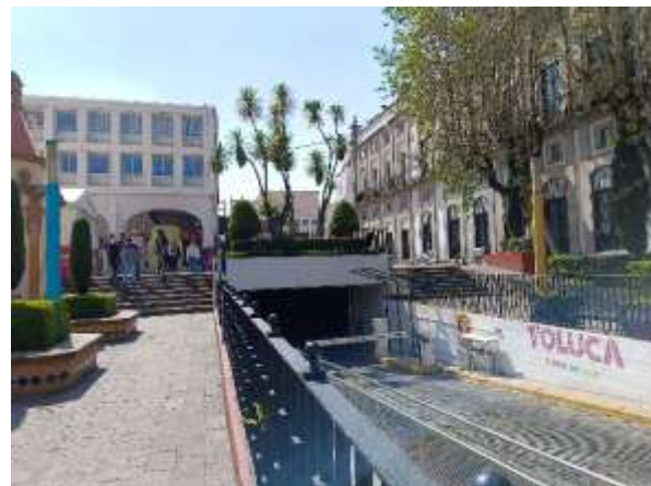
Fotografía 23 Entrada estacionamiento Independencia.
