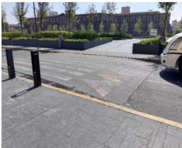
Fotografía 5 Paso a nivel de calle.
