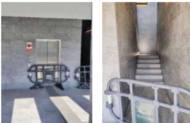
Fotografías 11 y 12 elevador y escaleras.
