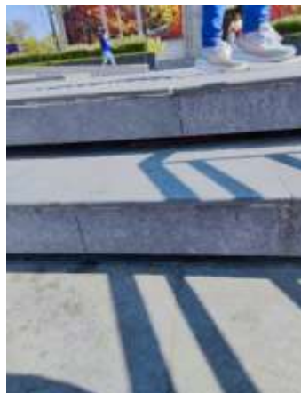
Fotograf3a 2 detalle escalones.
